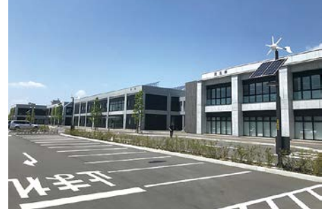
環境創造センター全景
