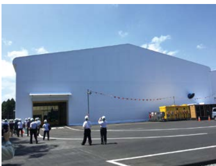
幅×奥行: 約 40×120 m×軒高 15 m のテントの中で分別を実施。 二重扉で負圧を保ち、粉じんのな どの汚染拡散を防いでいます (中間貯蔵施設)
