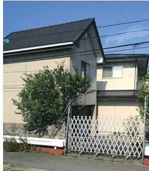
個人宅へ進入禁止のバリケード
