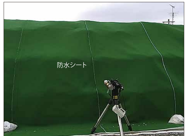
(b) 遮蔽土嚢設置後
