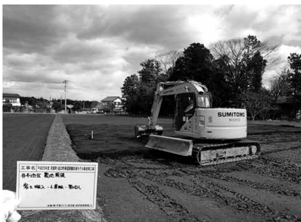
写真4 農地の除染状況(覆土)
