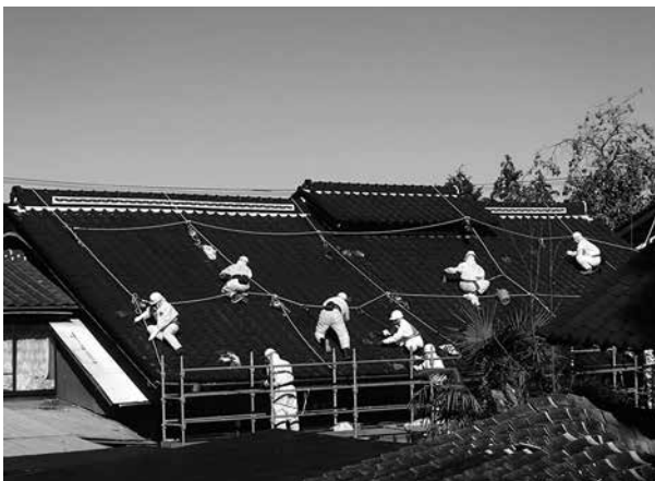
写真1 住宅屋根の除染状況
