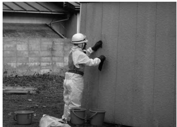
写真2 住宅外壁の除染状況
