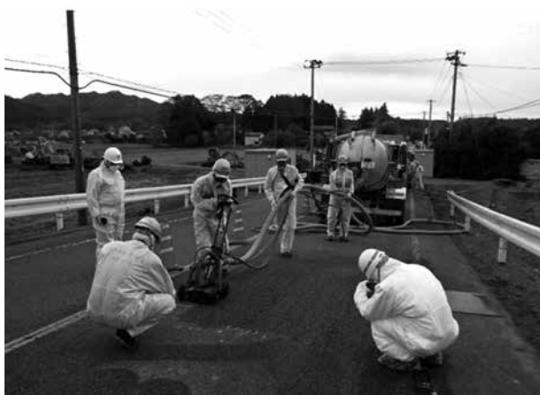
写真5 道路(舗装面)の除染状況(超高压水洗浄)
