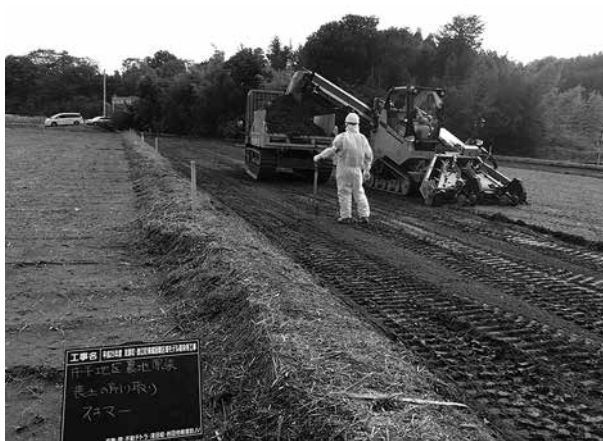
写真3 農地の除染状況(表土の剥ぎ取り)
