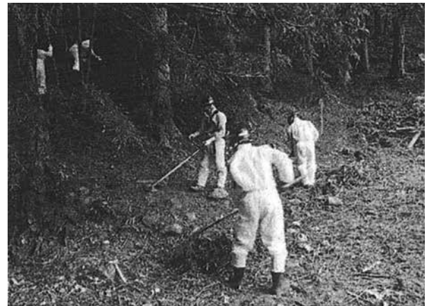
写真6 森林の除染状況(落葉等の堆積物除去)
