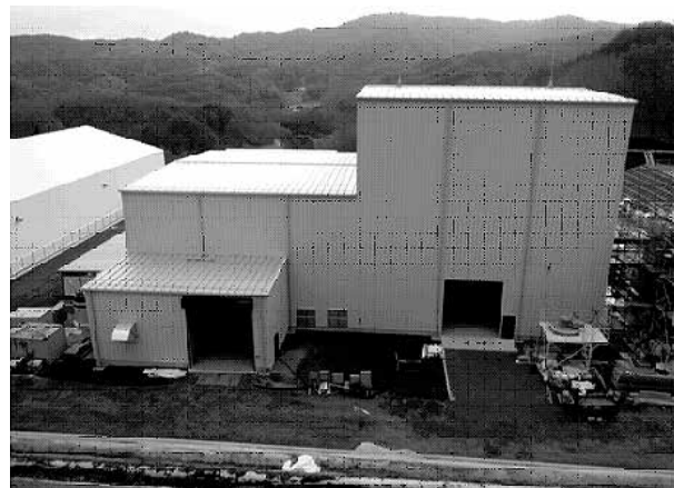
図2 仮設資材化実証施設
