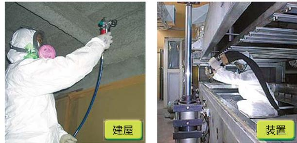
図3 ドライアイスブラストによる洗浄状況(既往の用途)
