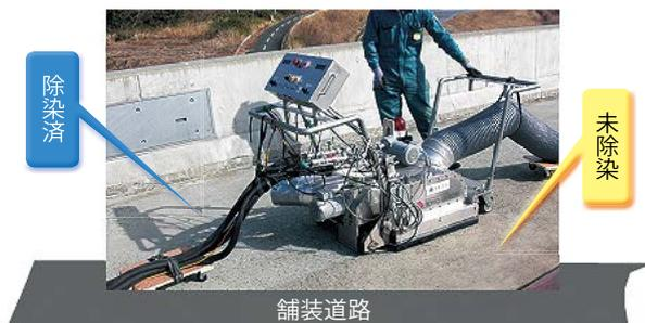
図 28 常磐道除染工事での実施状況
