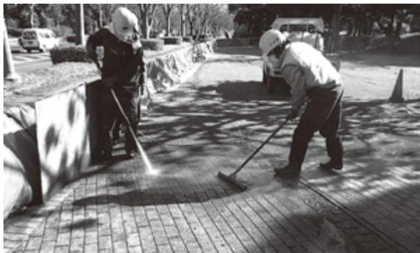
Fig.4 高圧洗浄による舗装道路の除染作業
