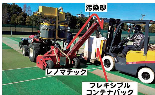
Fig. 2 レノマチックでの汚染砂の抜き取り作業中
