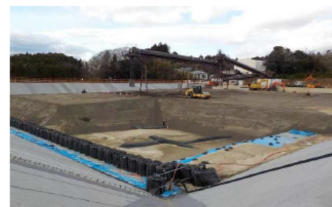
土壌貯蔵施設(双葉1期①工区)
