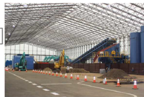
受入・分別施設(大熊1期②工区)
