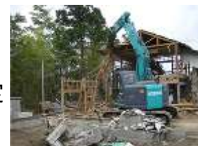
被災家屋等の解体
