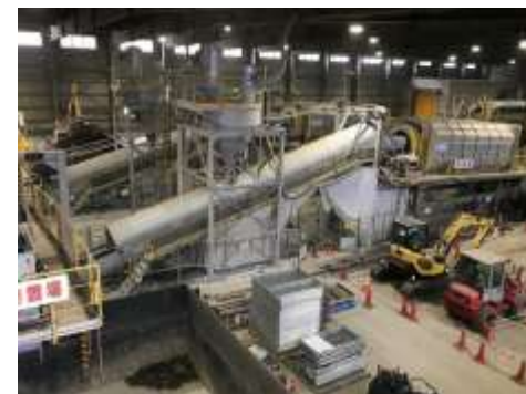
受入・分別施設(大熊①工区)
