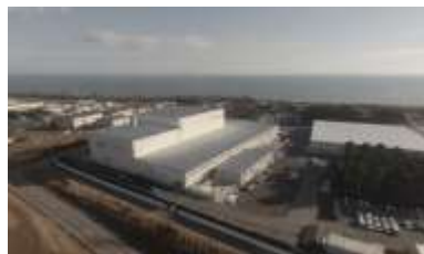
大熊町の仮設焼却施設
