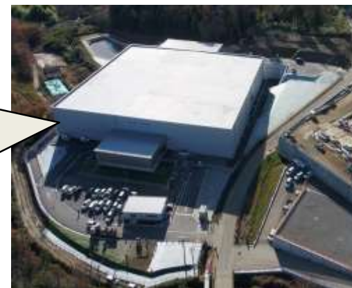
廃棄物貯蔵施設(双葉1工区)
