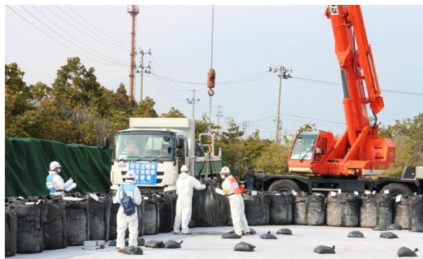
保管場への搬入・定置作業（大熊町内）
