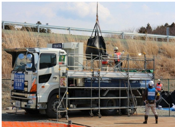
大熊町南平仮置場からの搬出作業
