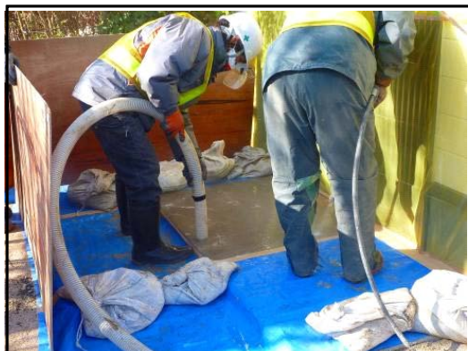
舗装道路の高圧水洗浄
