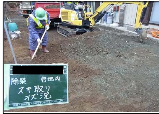
砕石・表土の除去、 きれいな土壌を用いた客土
