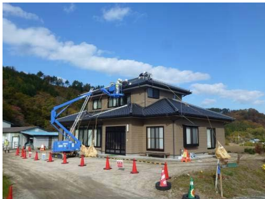
屋根上と壁面の拭き取り
