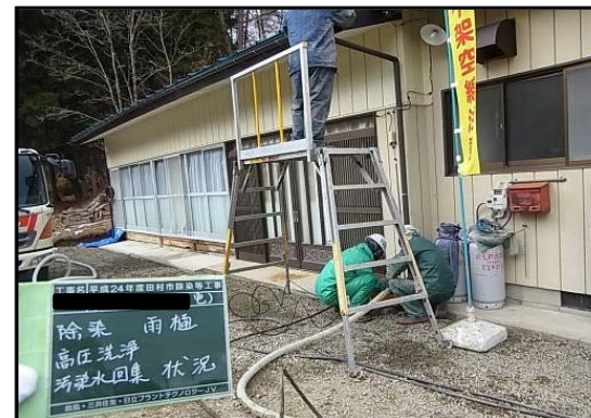
配水管の高圧水洗浄
