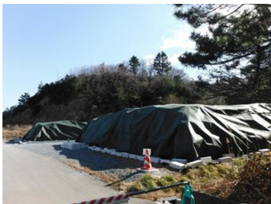
北部衛生センター仮置場(いわき市) 完了
