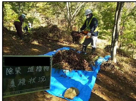
堆積物の刈り取り・汚泥の除去
