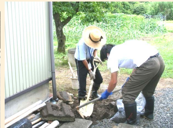
雨樋直下の地面は 高線量のため、線量を 計測しながら土壌除去
