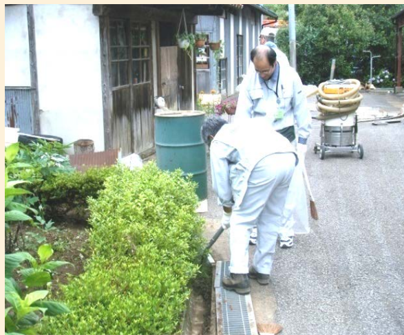
側溝汚泥の除去
