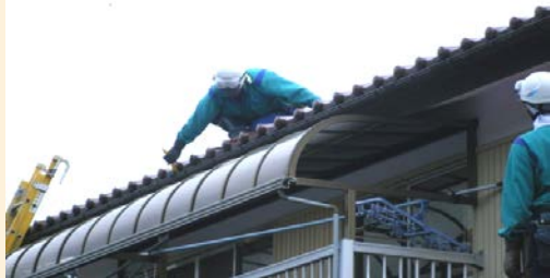
雨樋の汚泥除去
